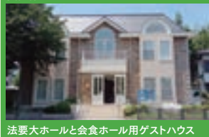
法要大ホールと会食ホール用ゲストハウス
