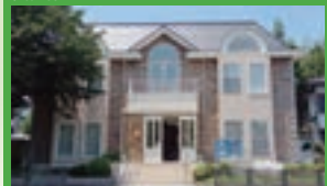
法要大ホールと会食ホール用ゲストハウス
