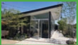
開放感のある管理棟
