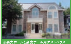
法要大ホールと会食ホール用ゲストハウス
