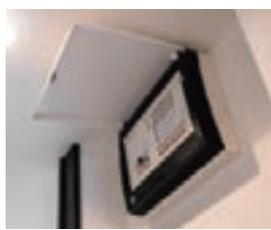
震度5の地震を感知して自動で電源を遮断
