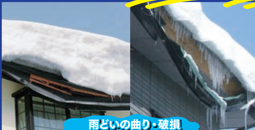
居住屋根の曲り・破損
