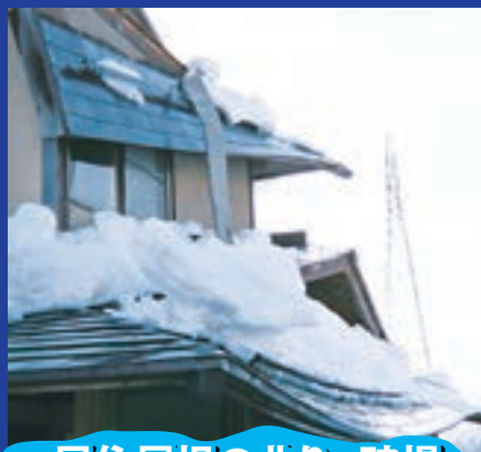
居住屋根の曲り・破損
