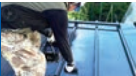
下処理から手塗で丁寧に塗り重ねて仕上げます。
