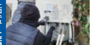
自社職人による安心施工。
