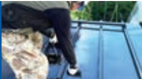
下処理から手塗で丁寧に塗り重ねて仕上げます。
