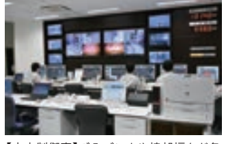
【中央制御室】ごみバンカや焼却炉など各設備の運転操作と監視を行っています。モニターで清掃工場全体の運転状況を把握できる場所です。
