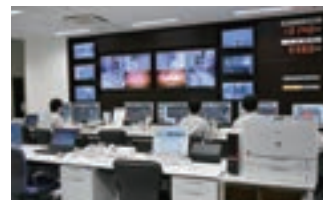
【中央制御室】ごみバンカや焼却炉など各設備の運転操作と監視を行っています。モニターで清掃工場全体の運転状況を把握できる場所です。
