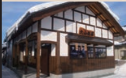
大山建築の特徴 しっかりとした躯体の和風建築
